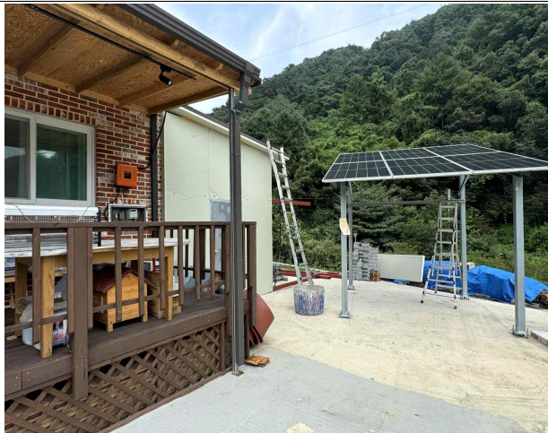
【사진 1】 공사 현장 전경
