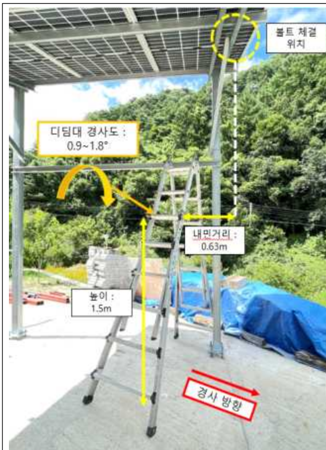
【사진 7】 작업발판 설치 상태
