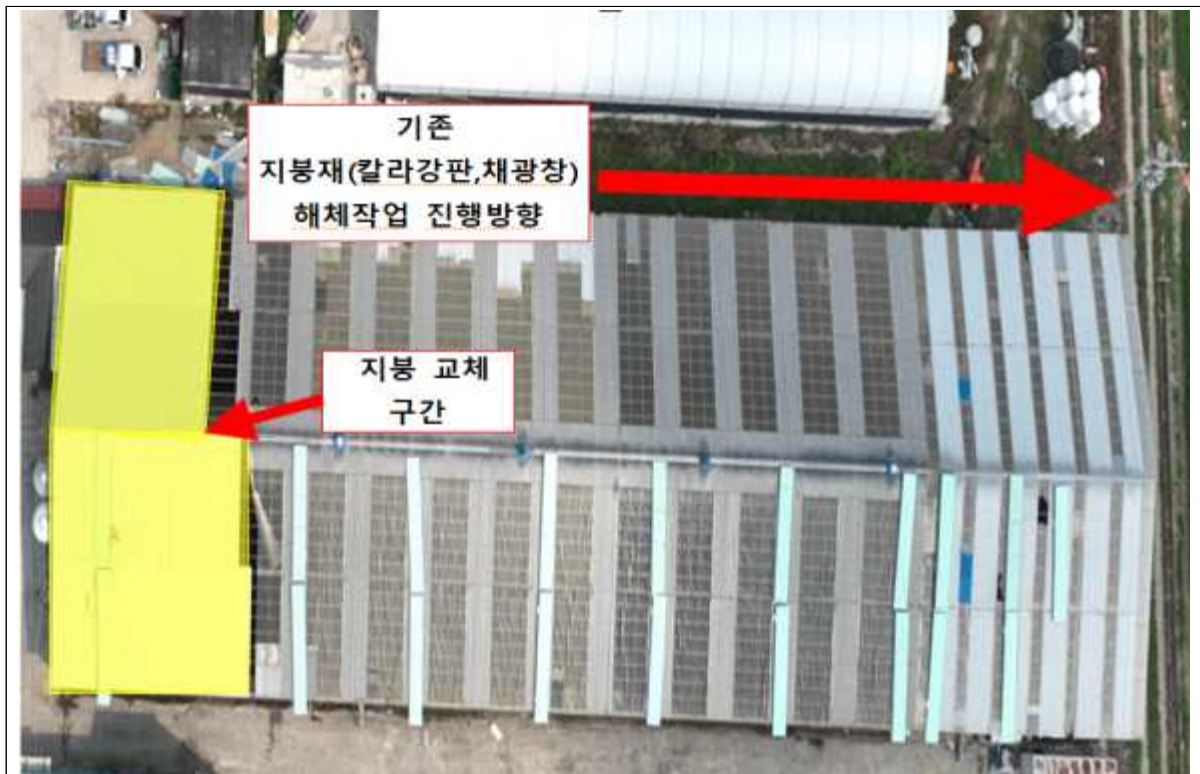
[사진2] 지붕재 교체작업 완료 구간 및 작업 해체진행 방향
