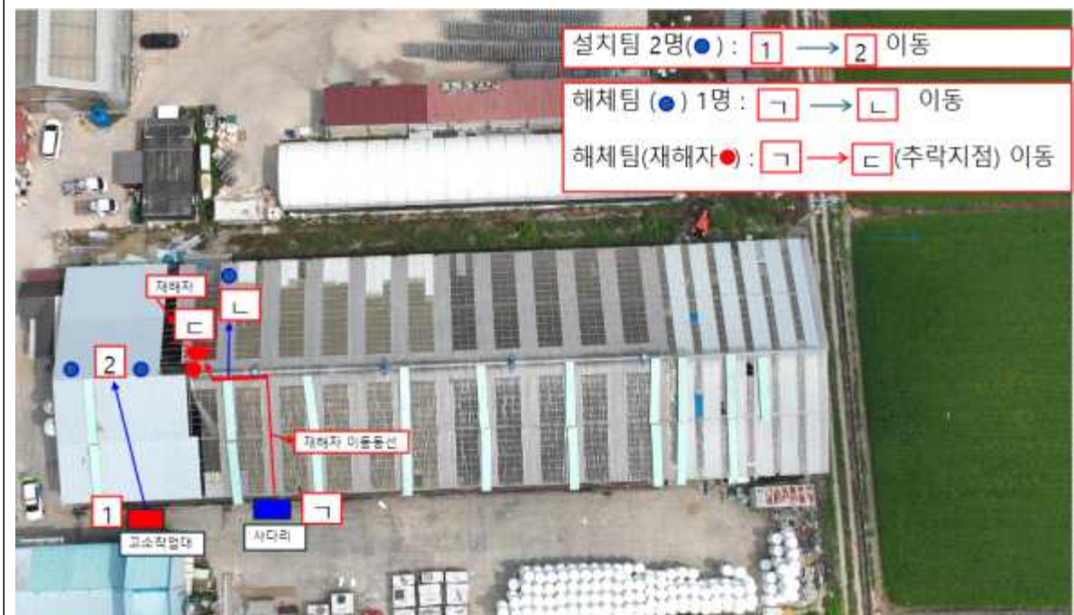
설치·해체작업자 이동동선 평면 (드론촬영)
