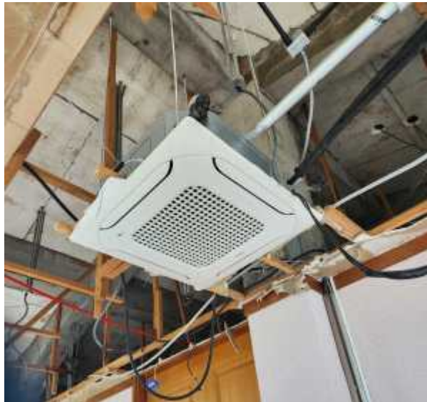
[ 사진 11, 12 ] 천장에어컨 고정상태 및 냉매배관 고정상태
