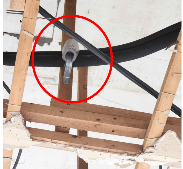
[ 사진 11, 12 ] 천장에어컨 고정상태 및 냉매배관 고정상태
