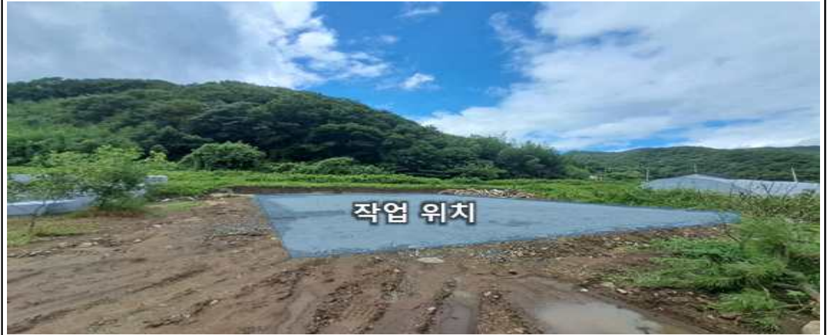
[사진1] 현장 전경
