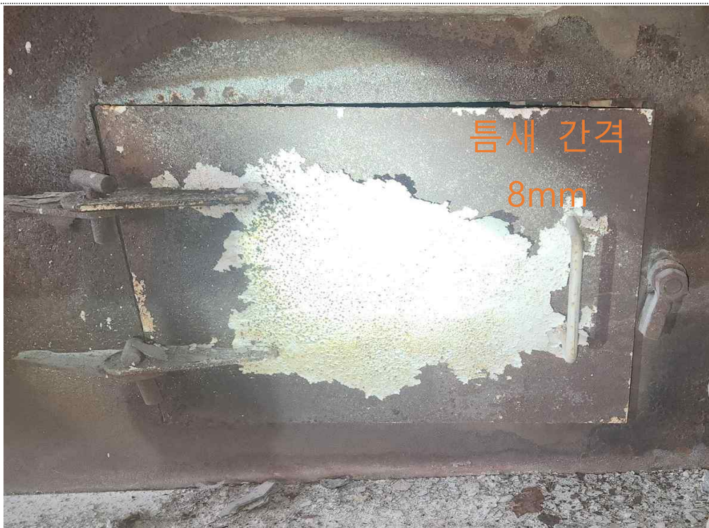
[사진 9] 2호기 하부 가열로 점검구 사진
