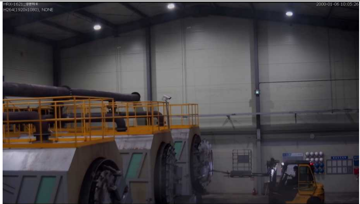
[사진 1] 지게차를 이용한 투입구 개방
